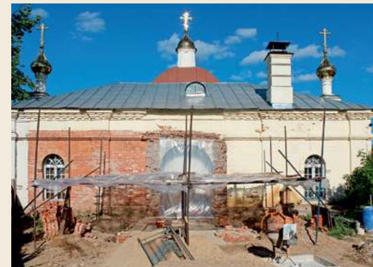
Строительство колокольни. 2012 г.
